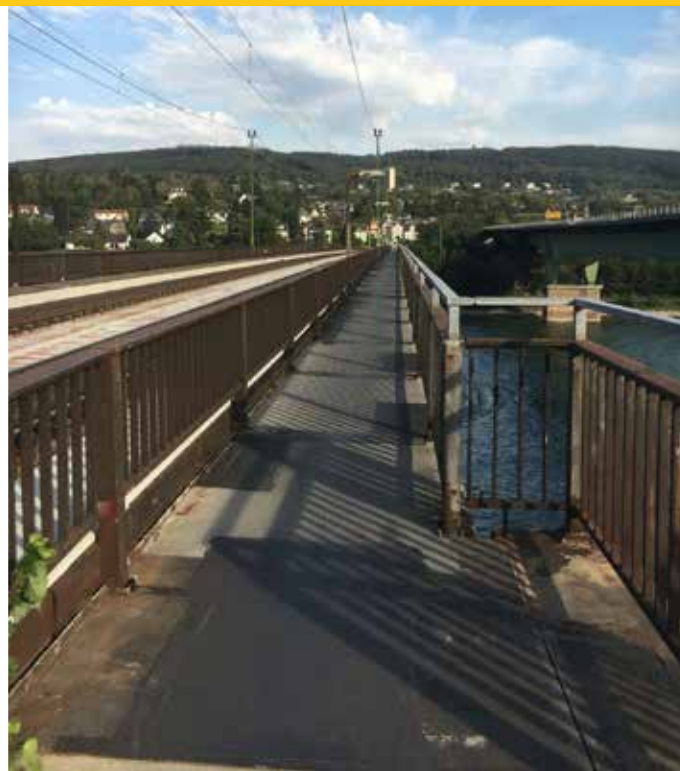
Nadelöhr seit vielen Jahren: Horchheimer Brücke - hier passen kaum 2 Fußgänger aneinander vorbei
